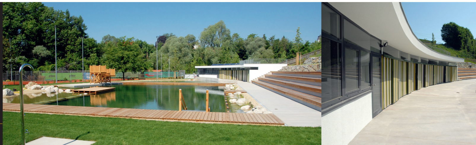
Das Dach des leicht gebogenen Betriebsgebäudes wird auch als Liegefläche genutzt.
